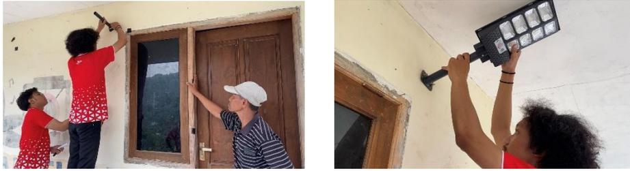
**Gambar 1.** Proses instalasi & penjelasan tentang lampu tenaga surya
