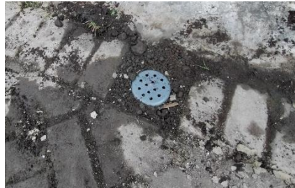
Gambar 5 Lubang Resapan Biopori yang telah ditanam
