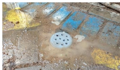
Gambar 4 Lubang Resapan Biopori yang telah ditanam
