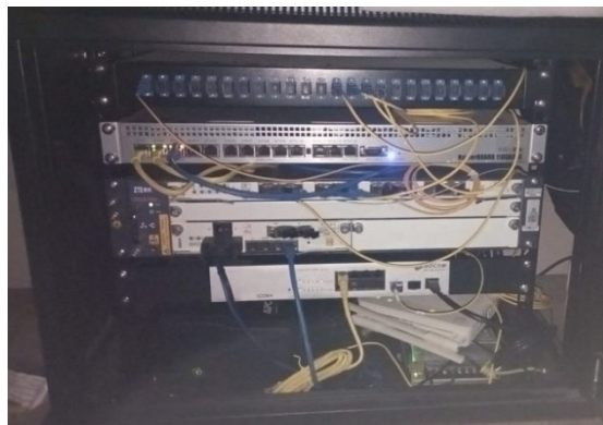
Gambar 5. Instalasi Router dan OLT di POP
